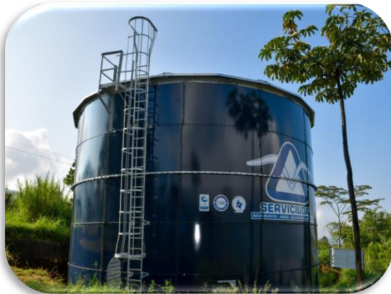
TANQUE EL RODEO 750 M3
