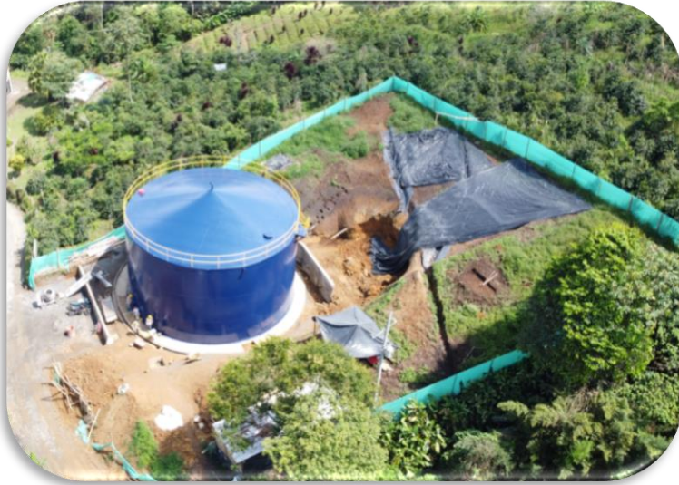
TANQUE LA DIVISA 1.200 M3
